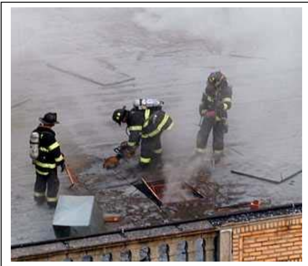
Fig. N°3: Las aberturas de techo también pueden ser realizadas en edificios, si contamos con la herramienta adecuada. La física de los gases es bastante simple a la hora de aplicarse al trabajo de los bomberos: Básicamente, los gases calientes provenientes de la combustión tienden a subir, generando una estratificación de las capas de aire dentro de una habitación, aumentando la Presión Parcial del \text{CO}_2 y disminuyendo la Presión Parcial de \text{O}_2 .
