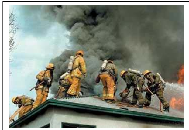
Fig. N°5: La Ventilación natural se realiza con diversas herramientas, permitiendo que las masas de aire caliente salgan de la estructura libremente. En la fotografía vemos un claro ejemplo de una ventilación vertical.
